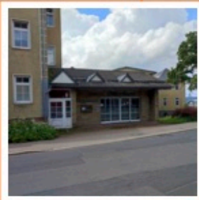
Rückbau Anbau -Foyer- ehem. "Hotel Oberland"!
